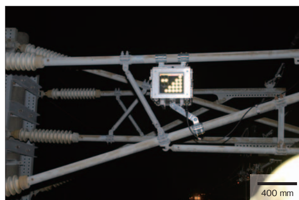
図2 光ファイバー式警報トロリ線の摩耗検知装置(柱上配置型) Fig. 2 Optical fiber wear-detection device
